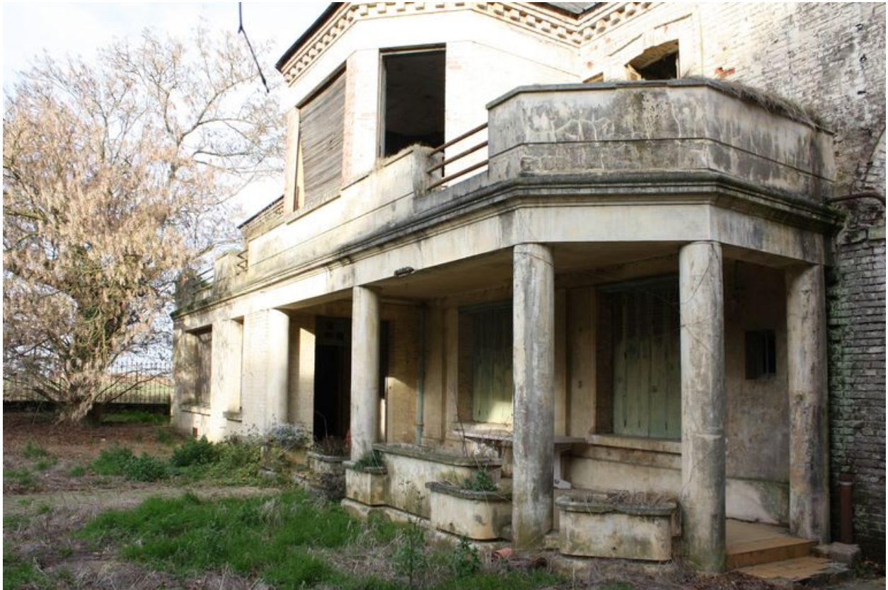
Terrasse en béton ajoutée au logement patronal, façade sur cour.
