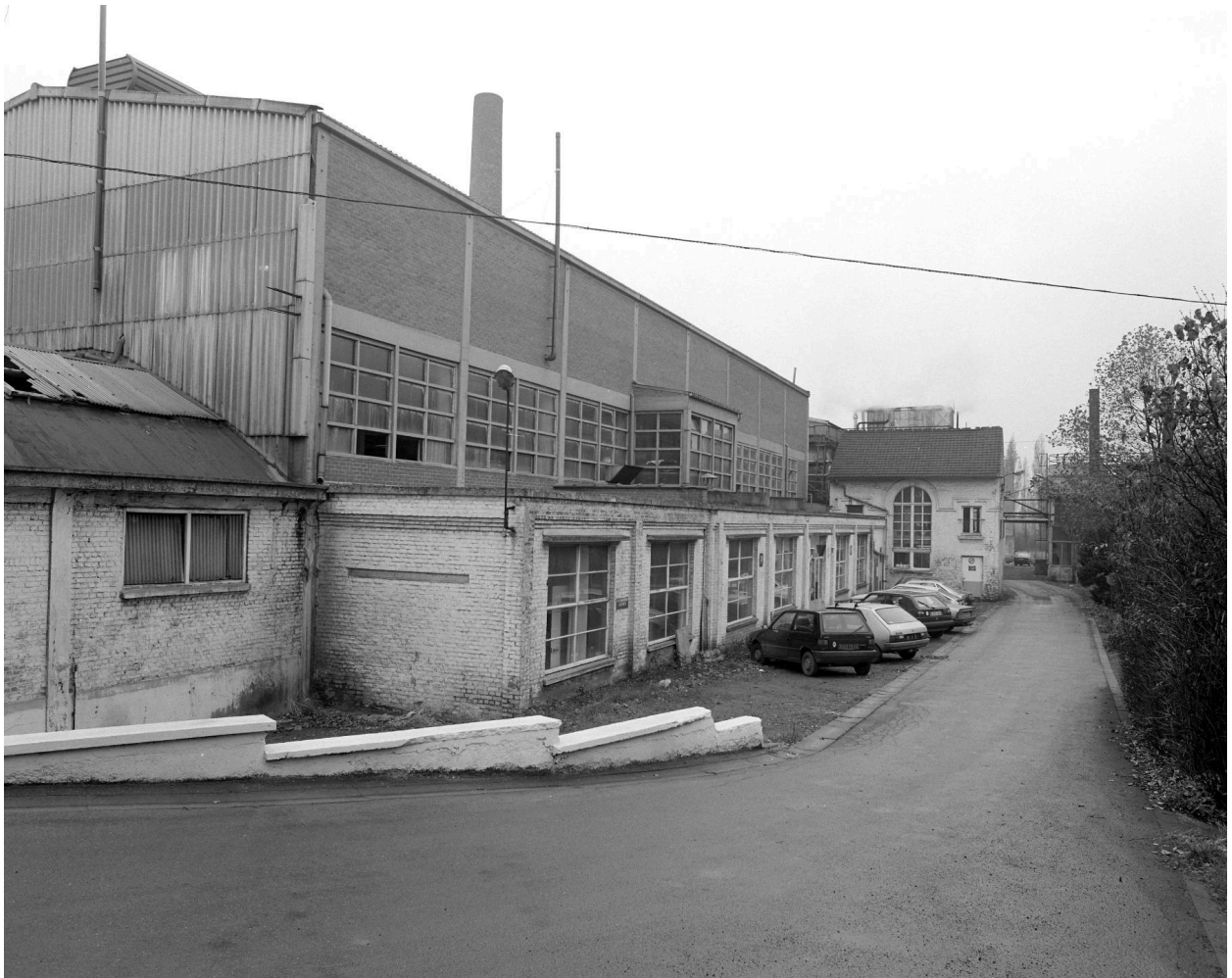
Atelier de fabrication (teinturerie) et salle des machines. Élévation sur cour. Vue prise vers le sud.
