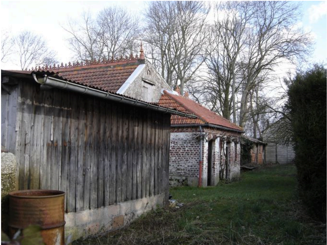
Etables à cochons adossées au pignon sud.
