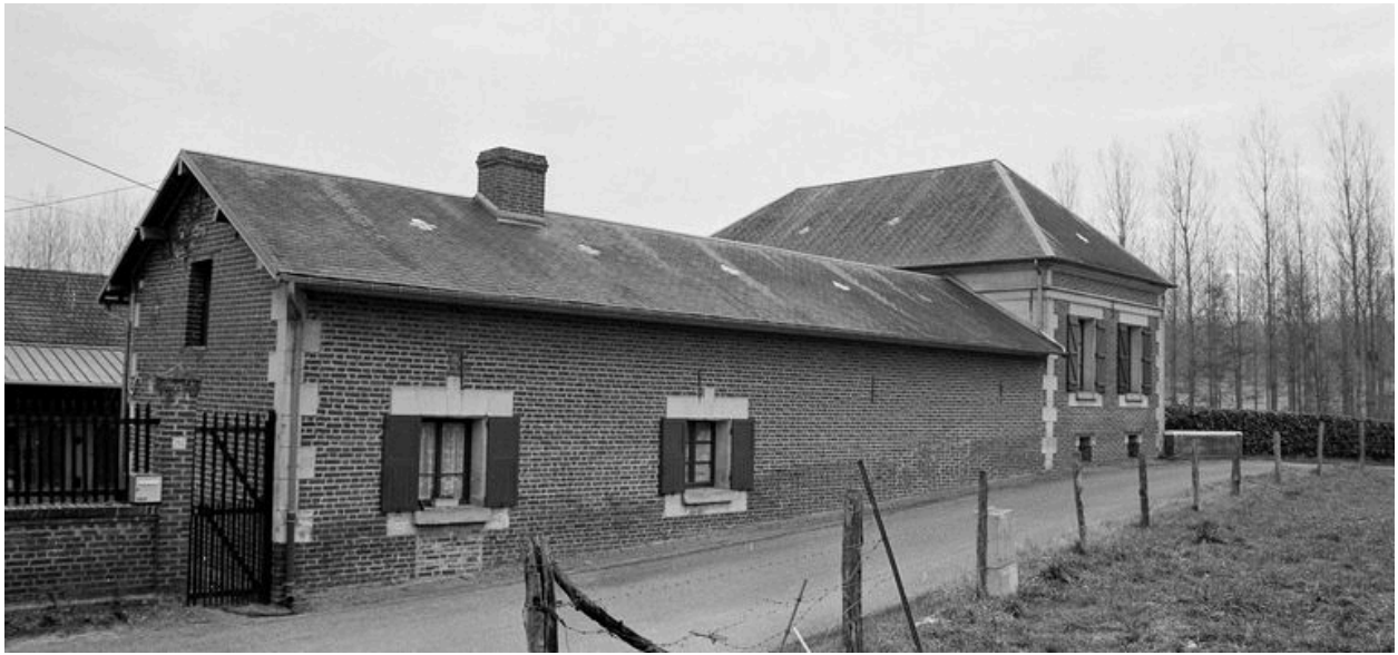
Maison d'habitation du moulin : façade sur rue.
