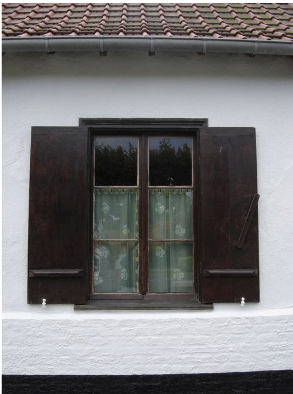
Détail d'une fenêtre.
