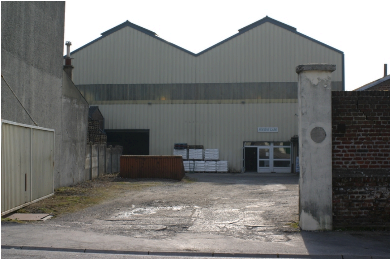
Cour et façade antérieure des entrepôts.
