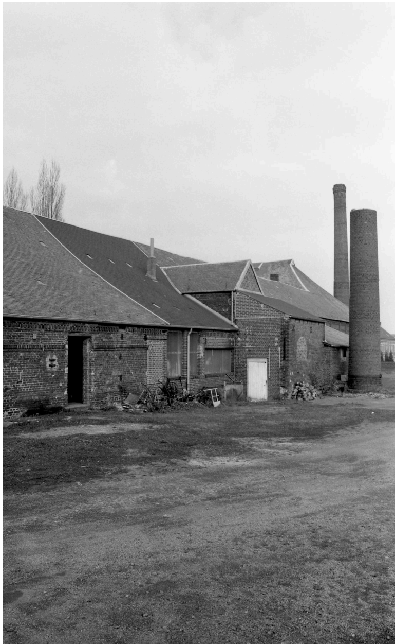
Les magasins et les halles de cuisson depuis le sud-est en 1989.
