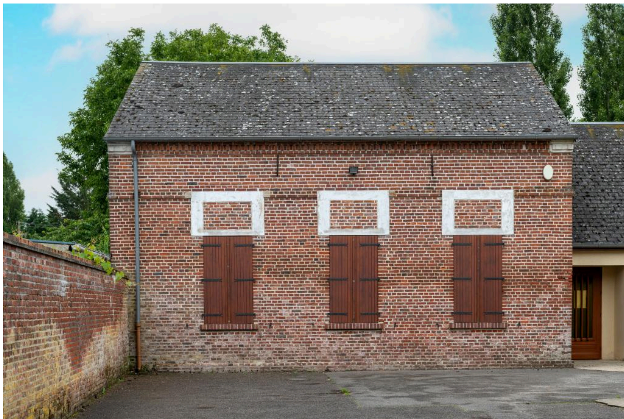
Bâtiment d'école derrière la mairie, 2e moitié 19e siècle, vue depuis l'est.
