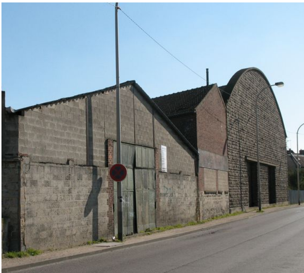
Façades des entrepôts depuis la gare.
