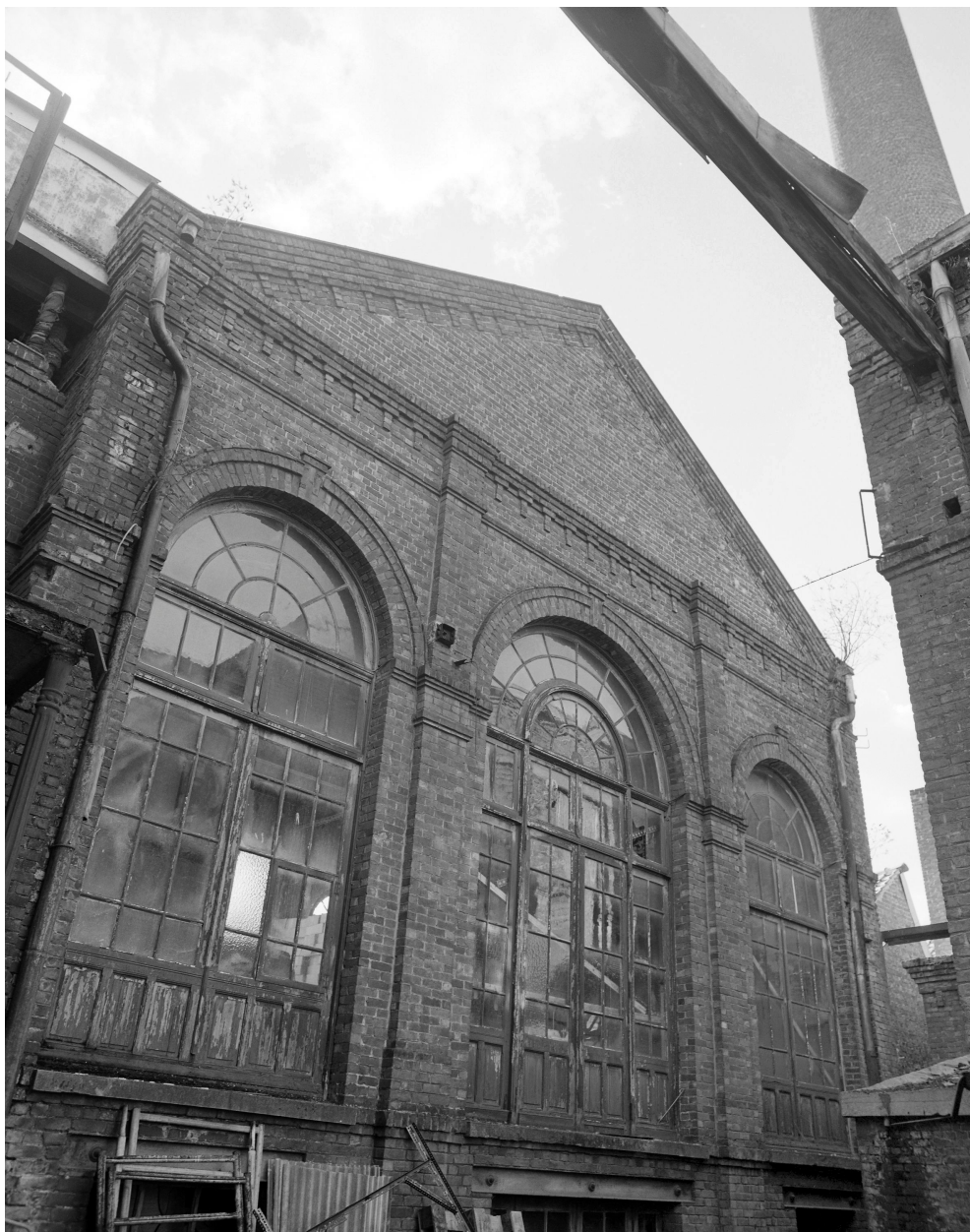
Seconde salle des machines. Élévation postérieure.
