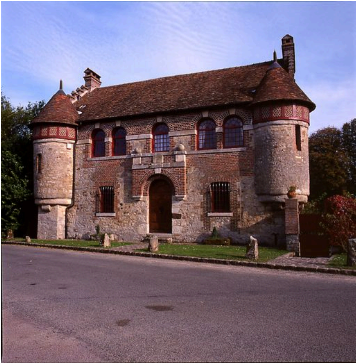
Vue d'ensemble de la façade principale.
