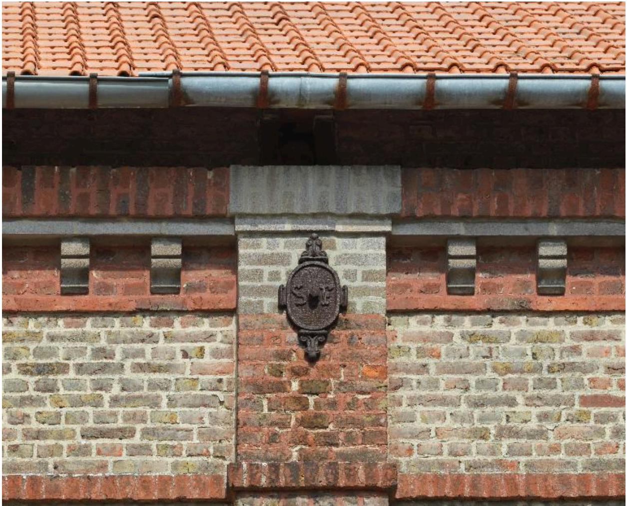
Détail d'un fer d'ancrage des entrepôts de l'usine portant les initiales SF.
