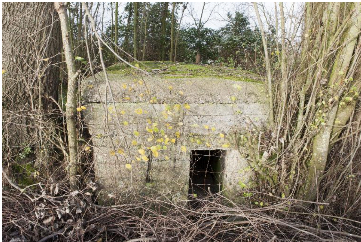
Casemate à munitions ? (611) : entrée sur l'émévation sud-est
