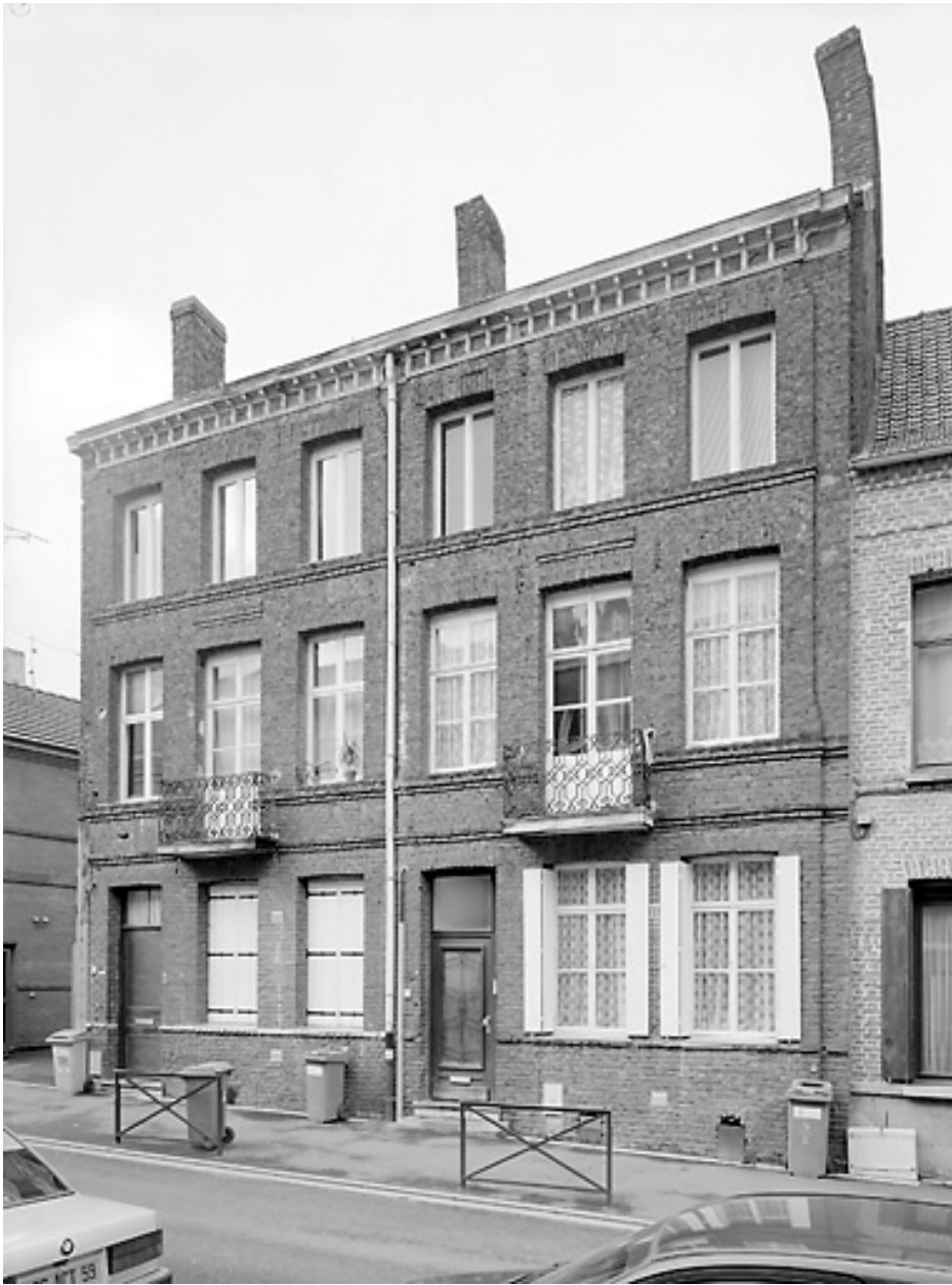
Vue générale des deux maisons (état en 2000).
