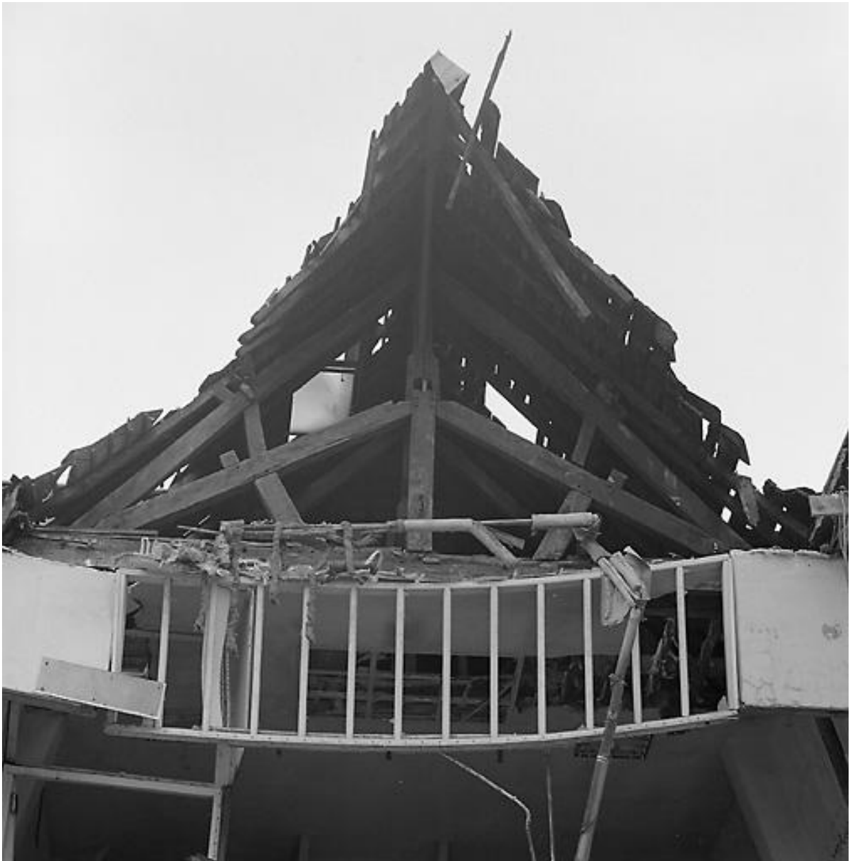
Bâtiment B, charpente.
