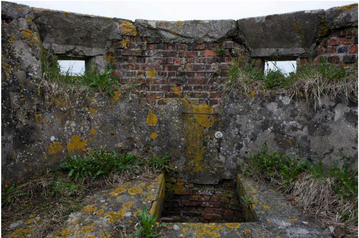
Vue de détail du dernier étage.
