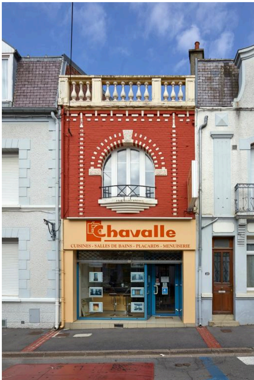
Maison, n° 26 place Faidherbe. Façade sur rue. Façade surmontée d'une balustrade, et portant un décor de briques blanches et un garde-corps de balcon à motifs Art Déco.
