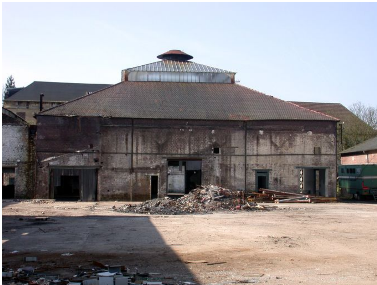
Vue d'ensemble du four de cuisson.
