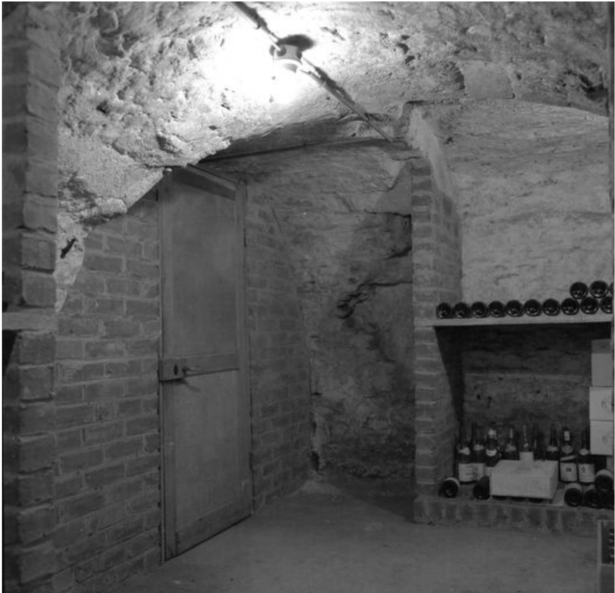
Sous-sol, vue partielle : cave médiévale et extension postérieure (travée de façade).
