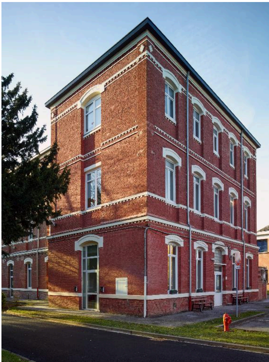
Bâtiment d'hospitalisation dit pavillon 9, élévation latérale droite donnant sur l'espace médian formant l'axe de l'établissement, vue de trois quarts gauche.
