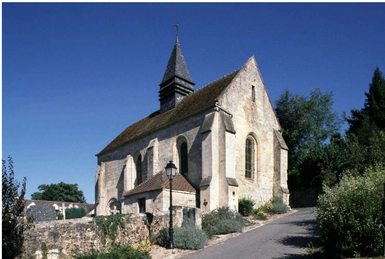
Vue générale sud de l'église.
