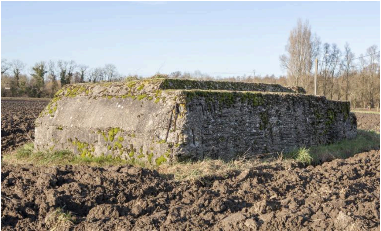
Vue de trois-quarts vers le nord.
