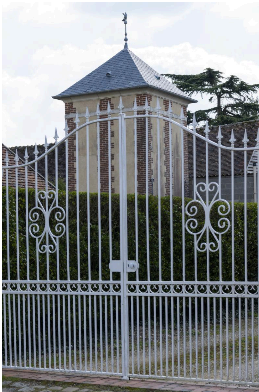
Ancien pigeonnier, n°13 rue de Bonlier, vue depuis le nord.
