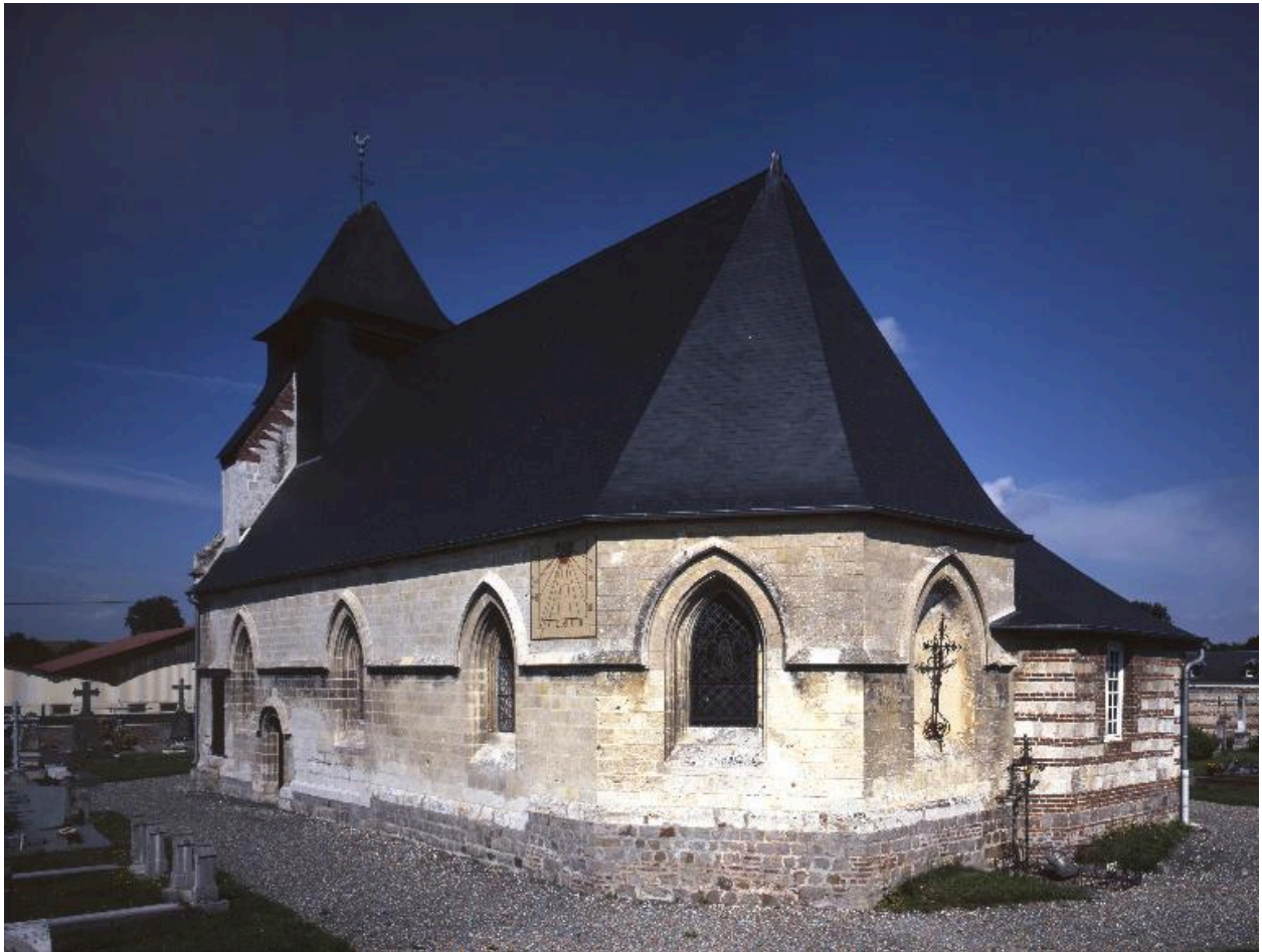
Vue générale du cimetière autour de l'église.
