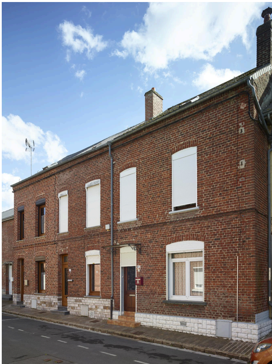
Exemple de maisons groupées du 1er quart du XIXe siècle - 27-31, rue Saint-François.
