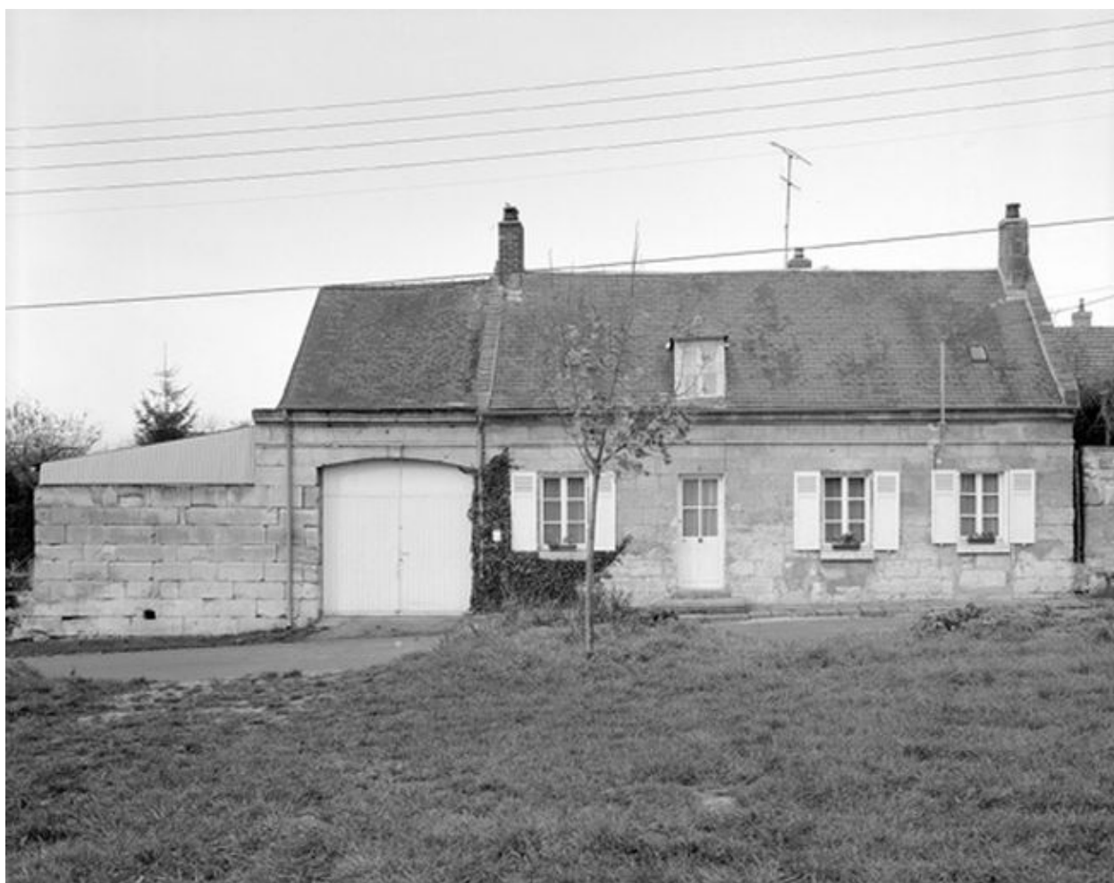
Logis. Vue générale.
