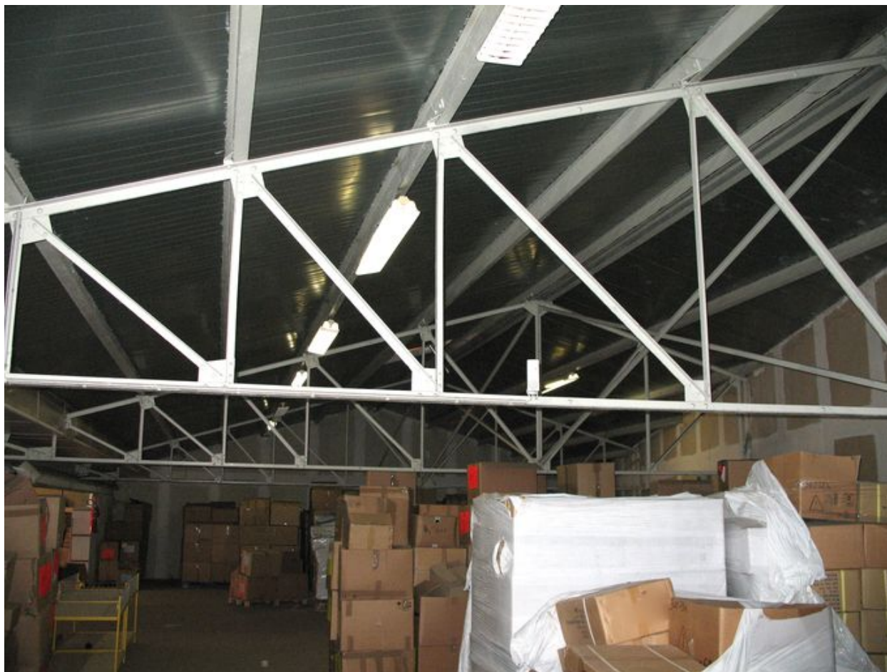
Charpente de l'un des entrepôts.
