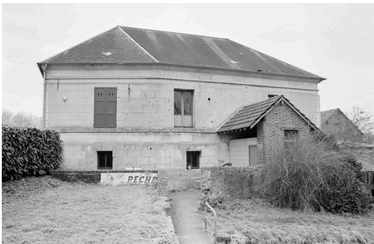
Atelier de fabrication doté de la cage de l'ancien moulin : façade postérieure.
