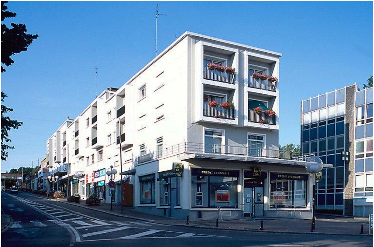
Vue générale de l'alignement est.
