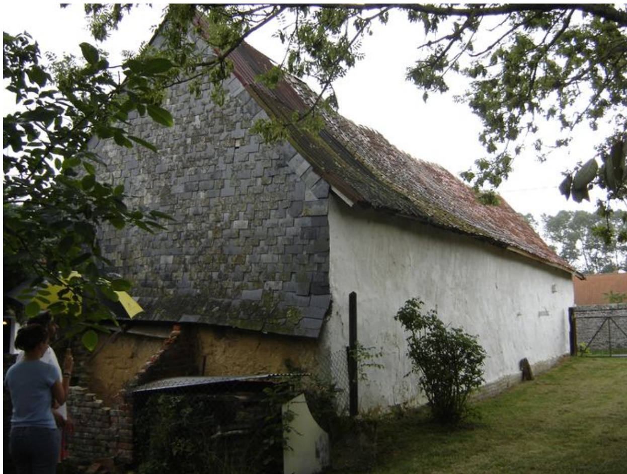
Vue postérieure du bâtiment.
