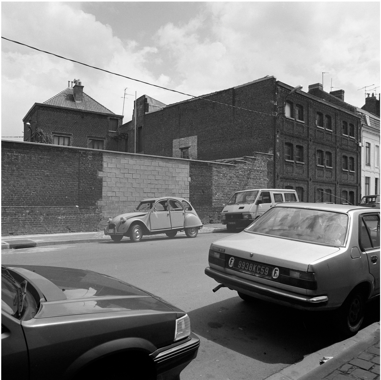
Vue générale depuis la rue du Nord.
