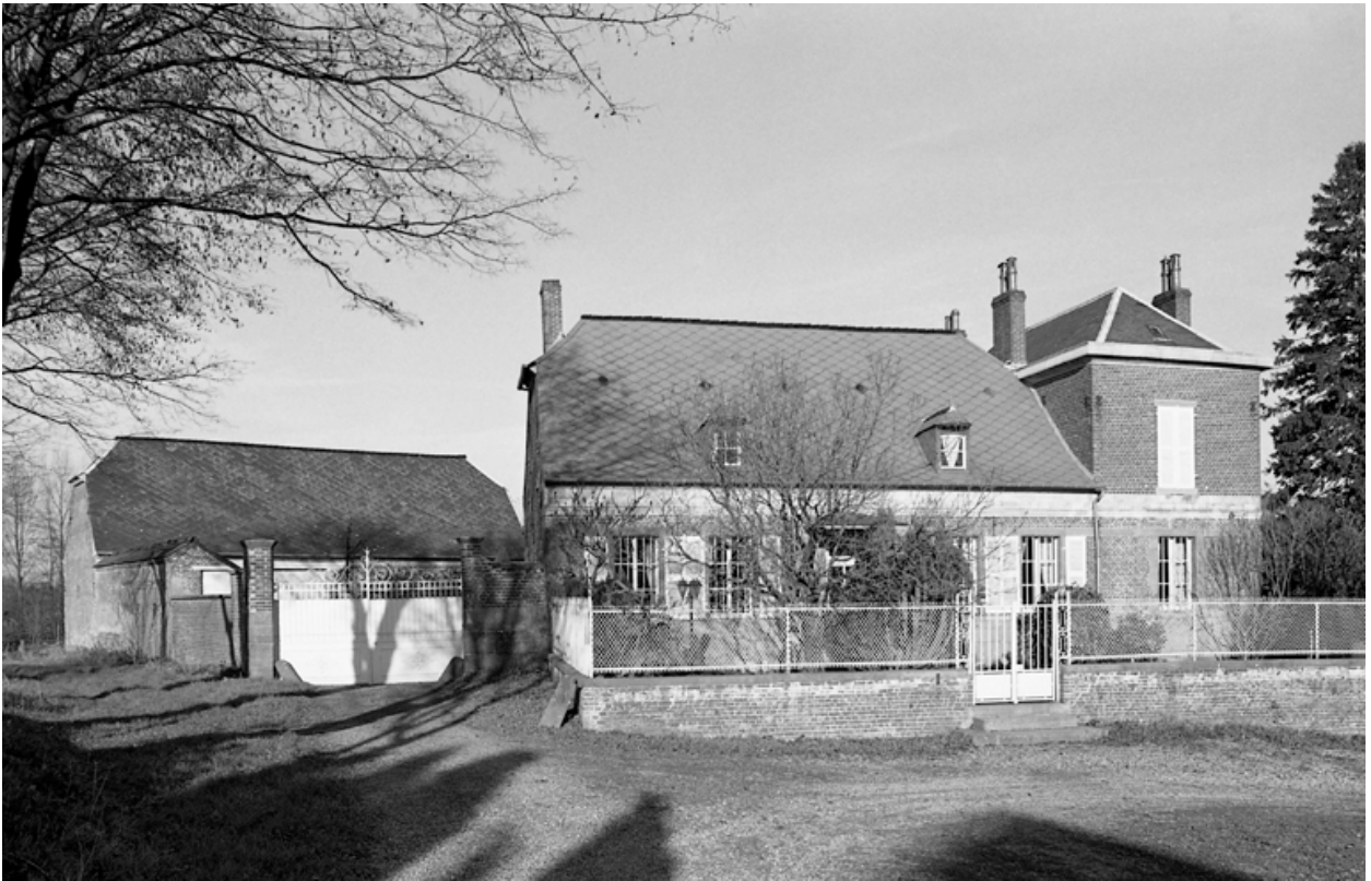
Vue générale sud-est du logis et de la grange.
