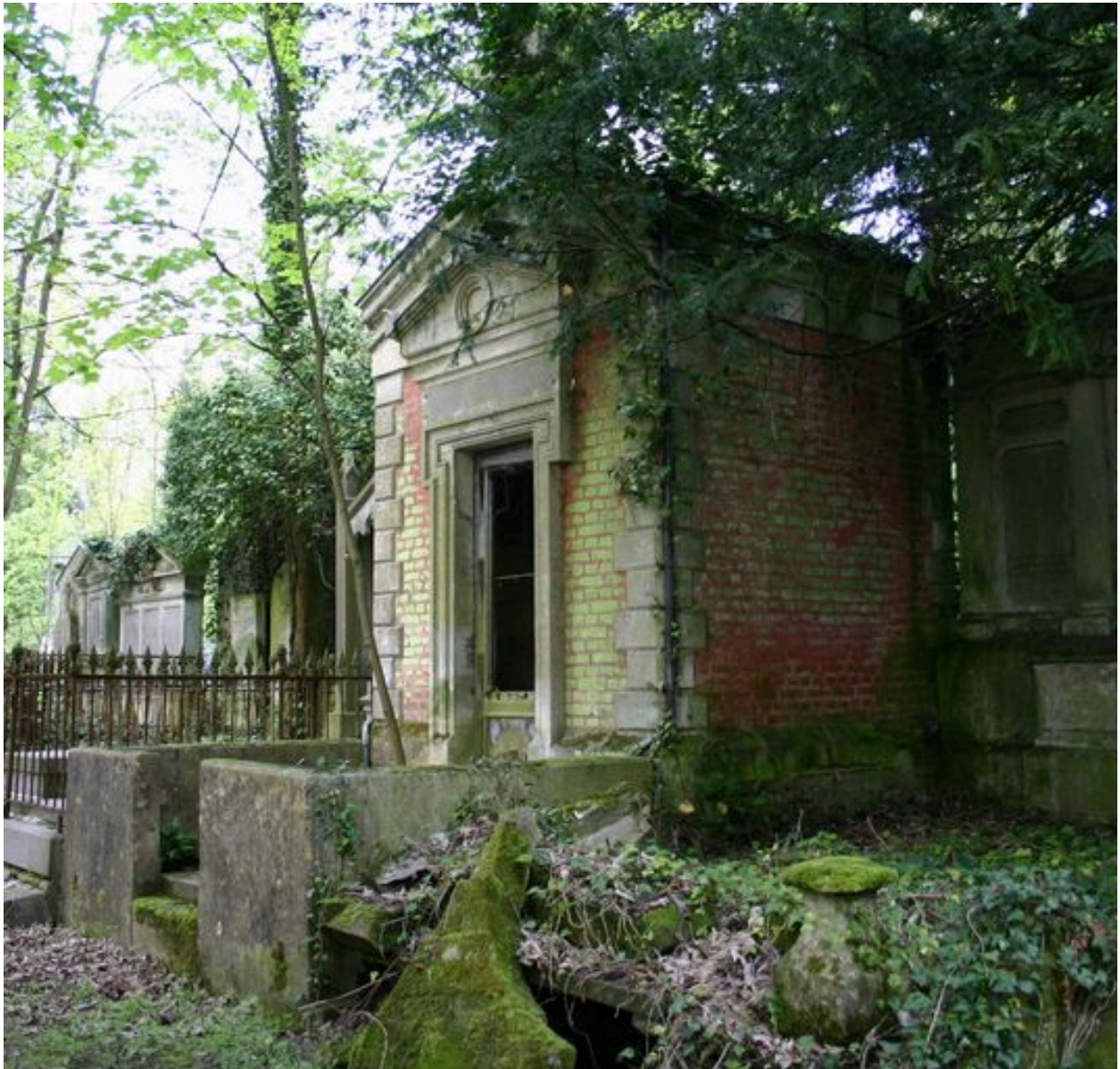
Vue générale, depuis le côté.
