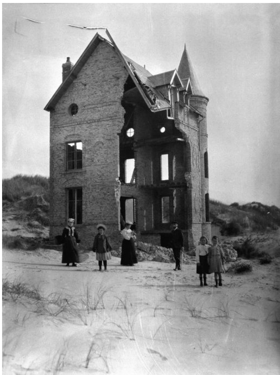
Villa détruite en front de mer, photographie (coll. part.).
