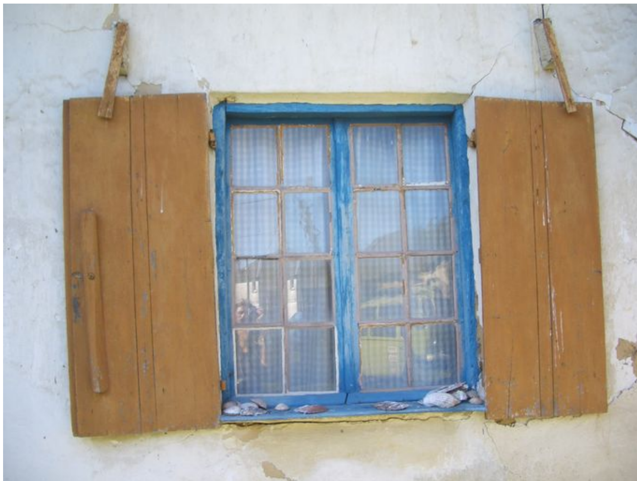
Vue d'un contrevent avec système d'attache à tourniquet.
