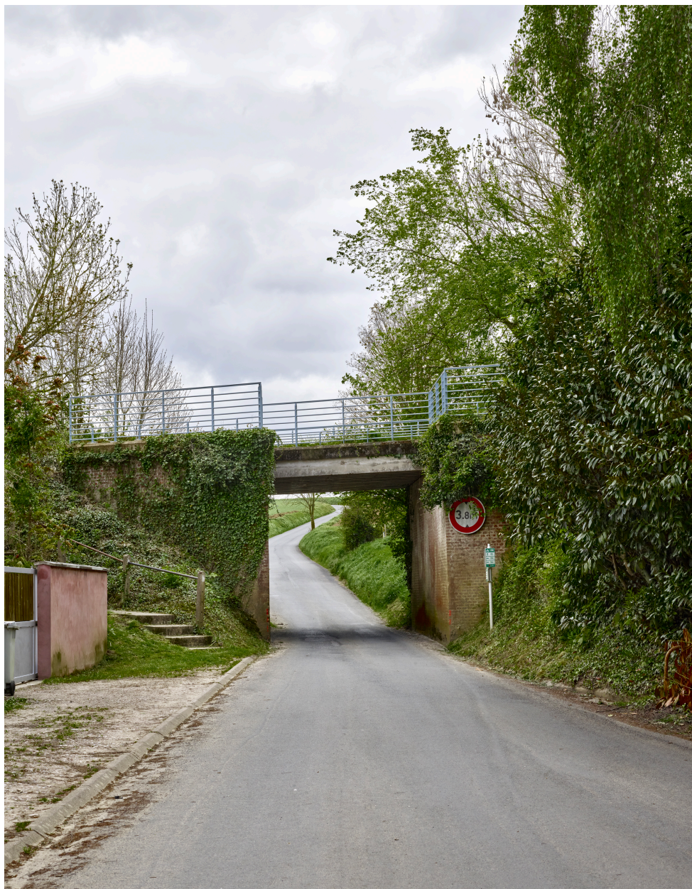
Ancien pont ferroviaire de la rue du Jeu de Tamis, depuis le nord.
