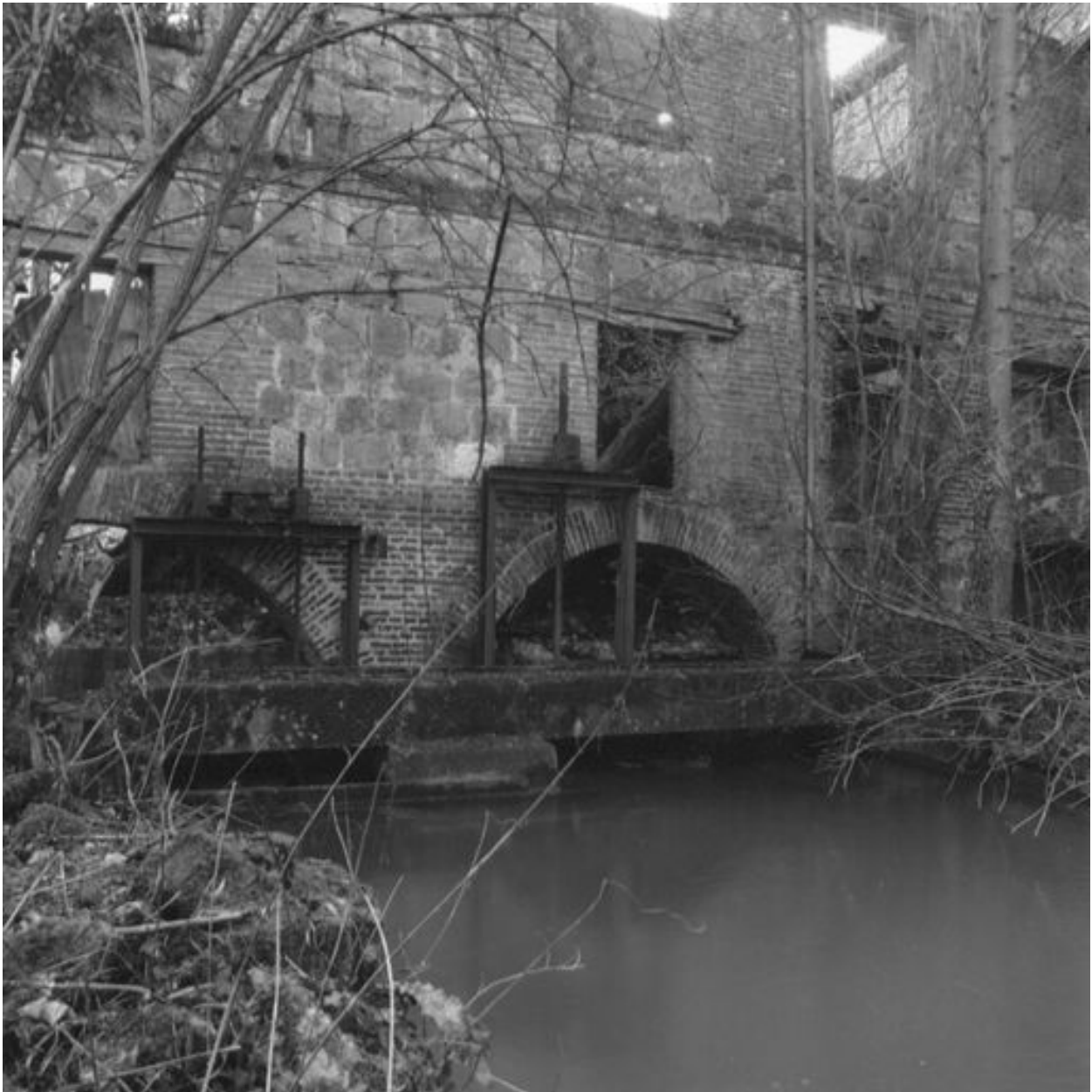
Les arches en plein cintre de la coulerie maçonnée du moulin
