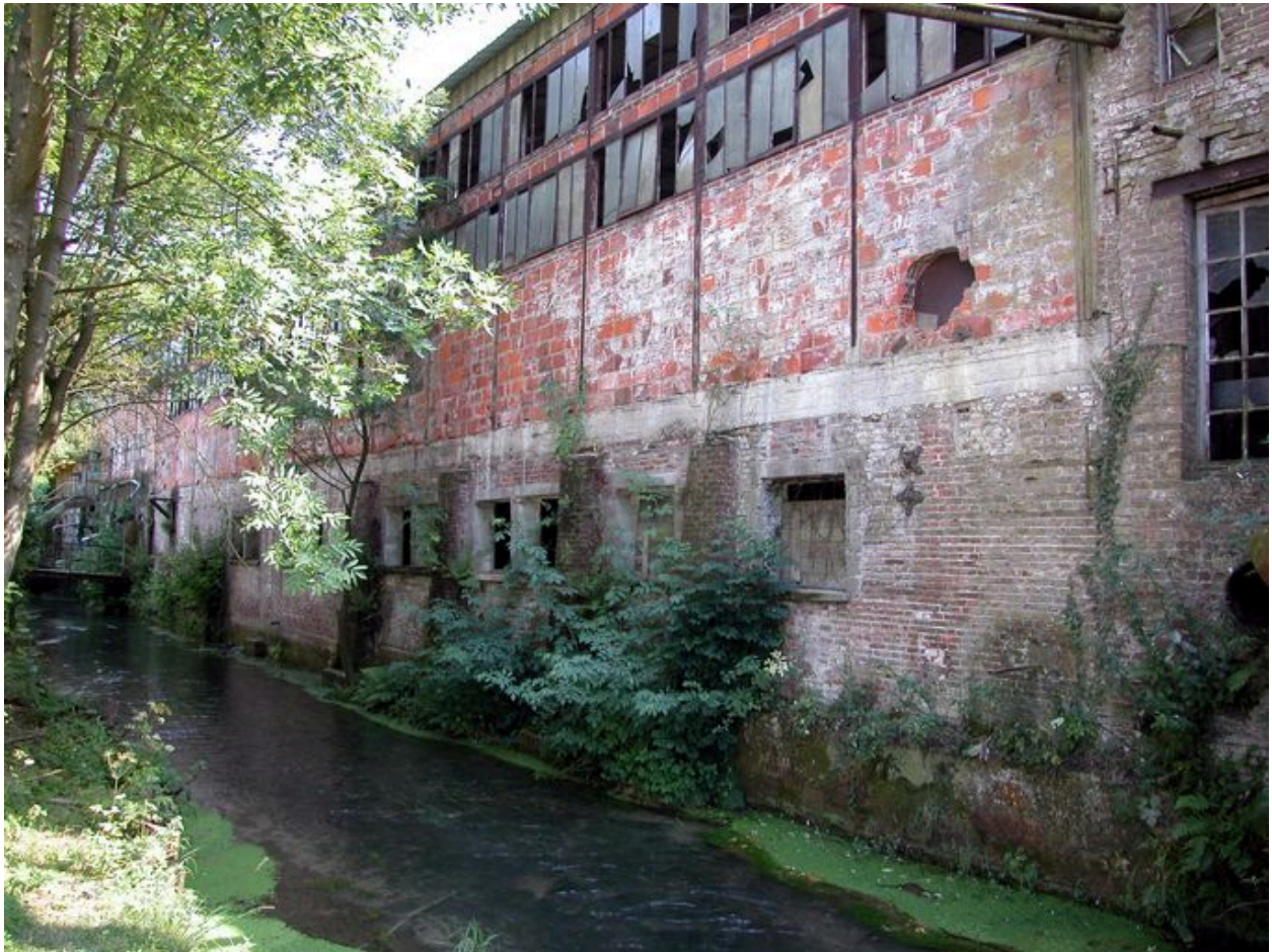
Façade sud des ateliers de fabrication de la fromagerie, donnant sur la rivière.
