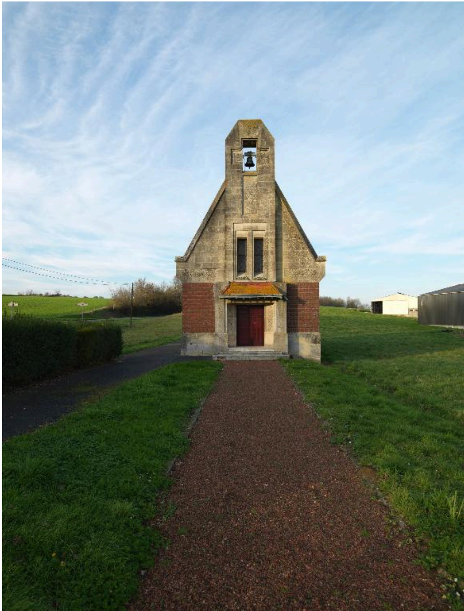
Vue de la façade principale, depuis le sud.
