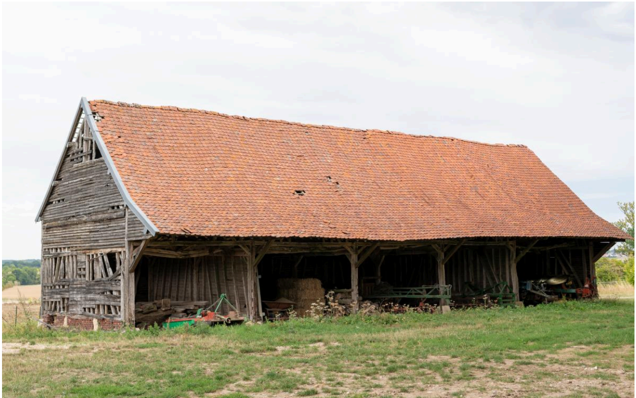
Ancien hangar agricole, vue depuis le sud-ouest.
