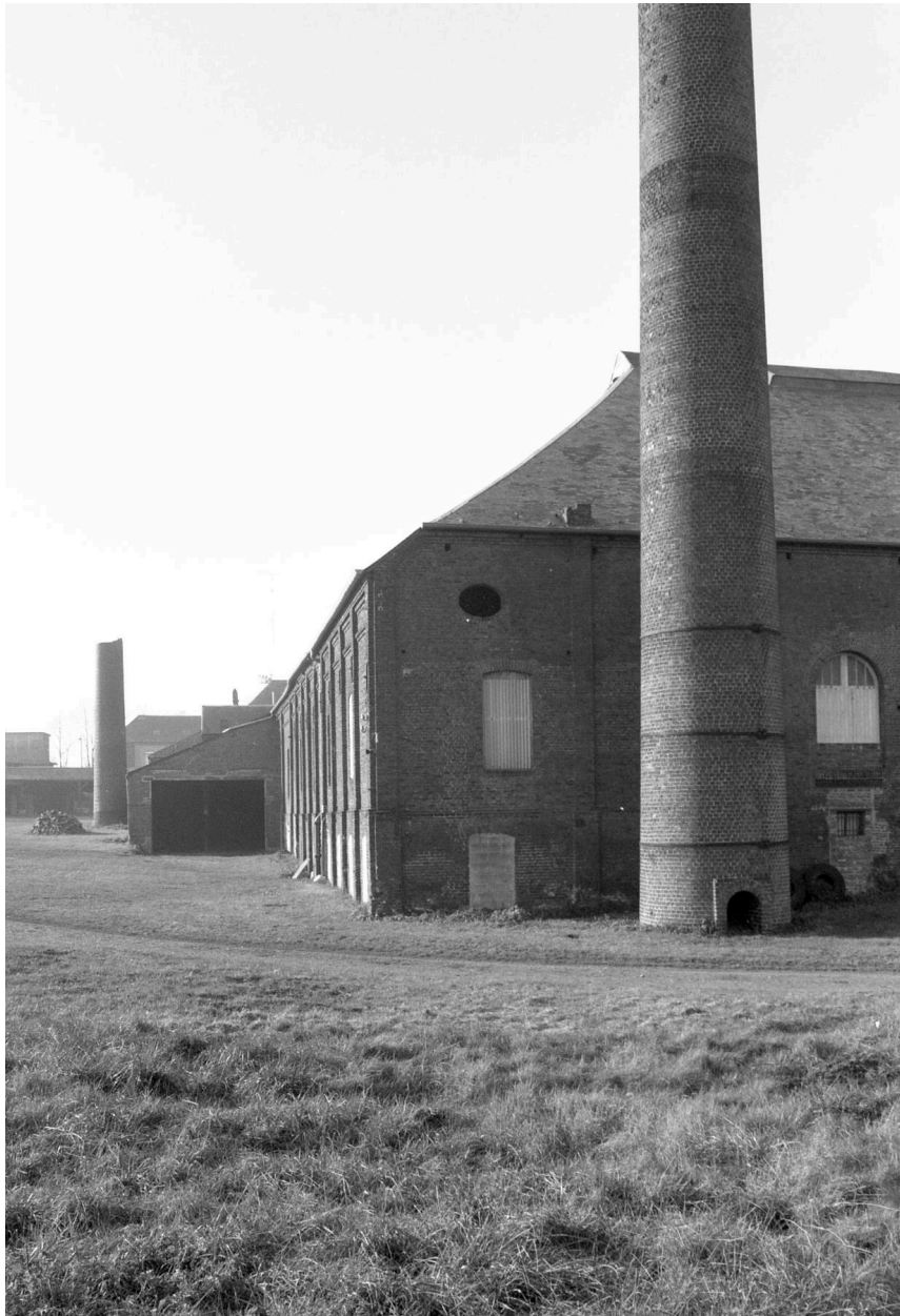
Angle nord-est de la halle des fours, du bâtiment en retour et des cheminées, en 1989.
