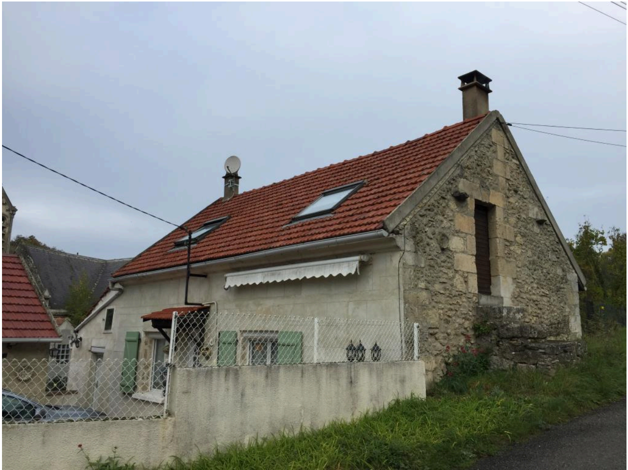
Vue de la façade sud-ouest sur cour et du pignon sud-est ouvrant sur le chemin.
