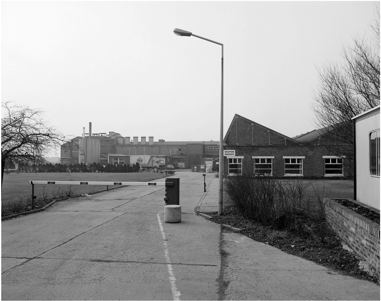
Bureaux, atelier de fabrication.
