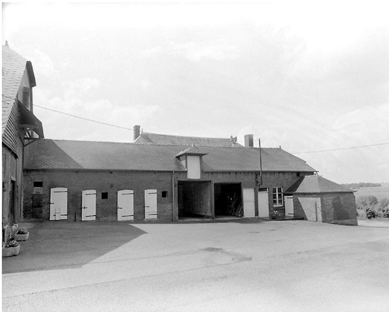
Grange, étable à chevaux et remise agricole.
