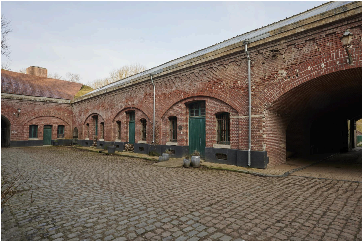
Aile est de la caserne de gorge, actuellement musée du fort de Seclin. Élévation sur cour.
