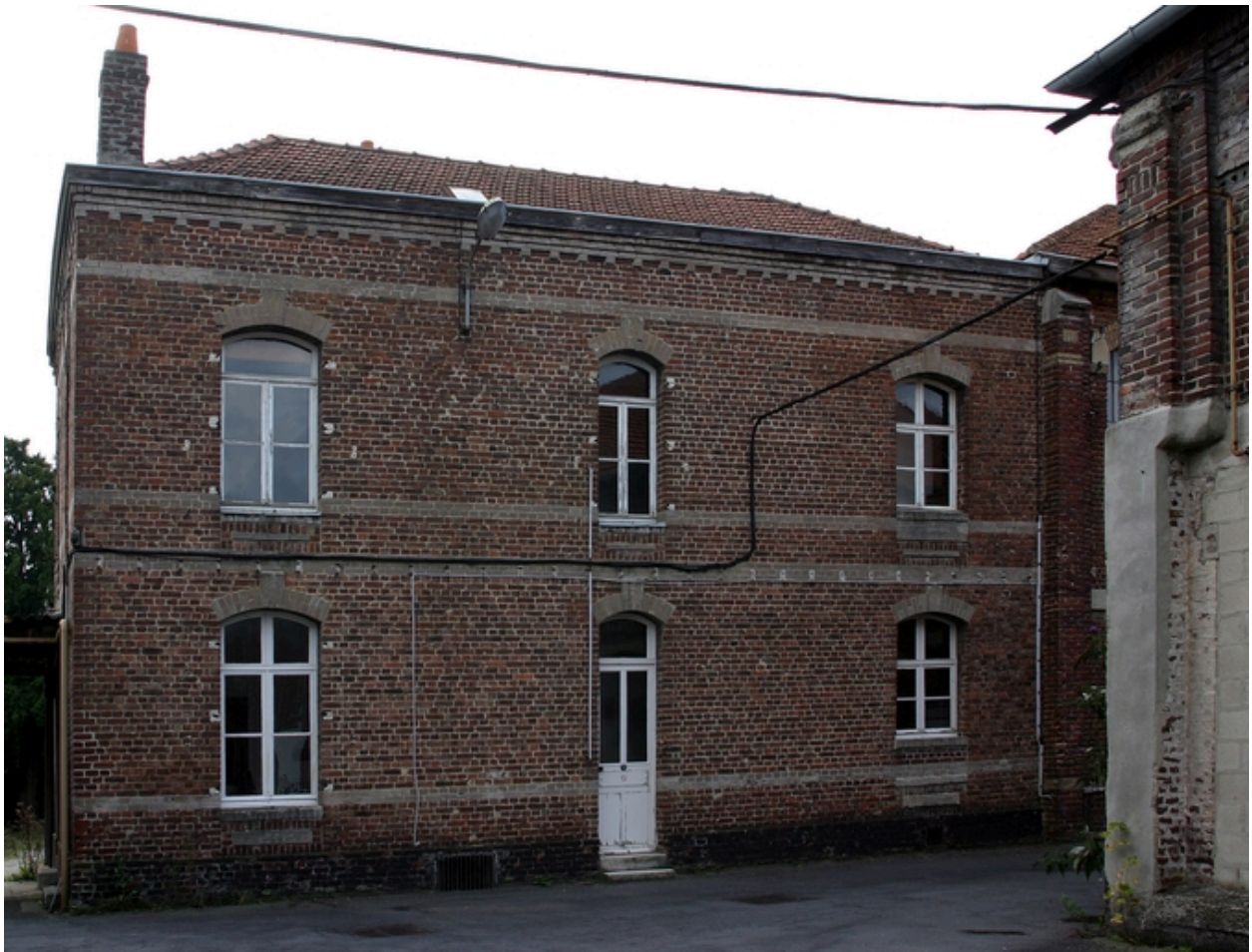
Façade antérieure du logement de contremaître.
