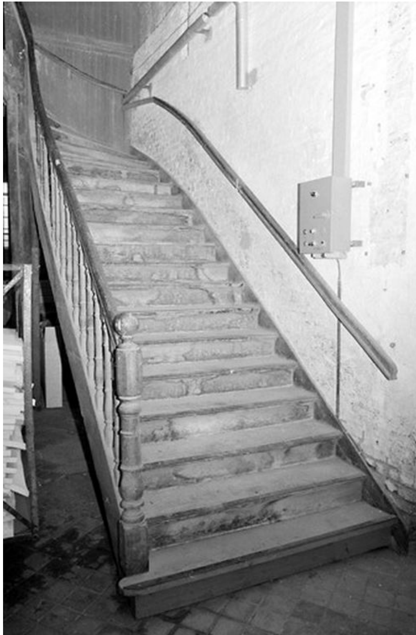
Vue intérieure : escalier.
