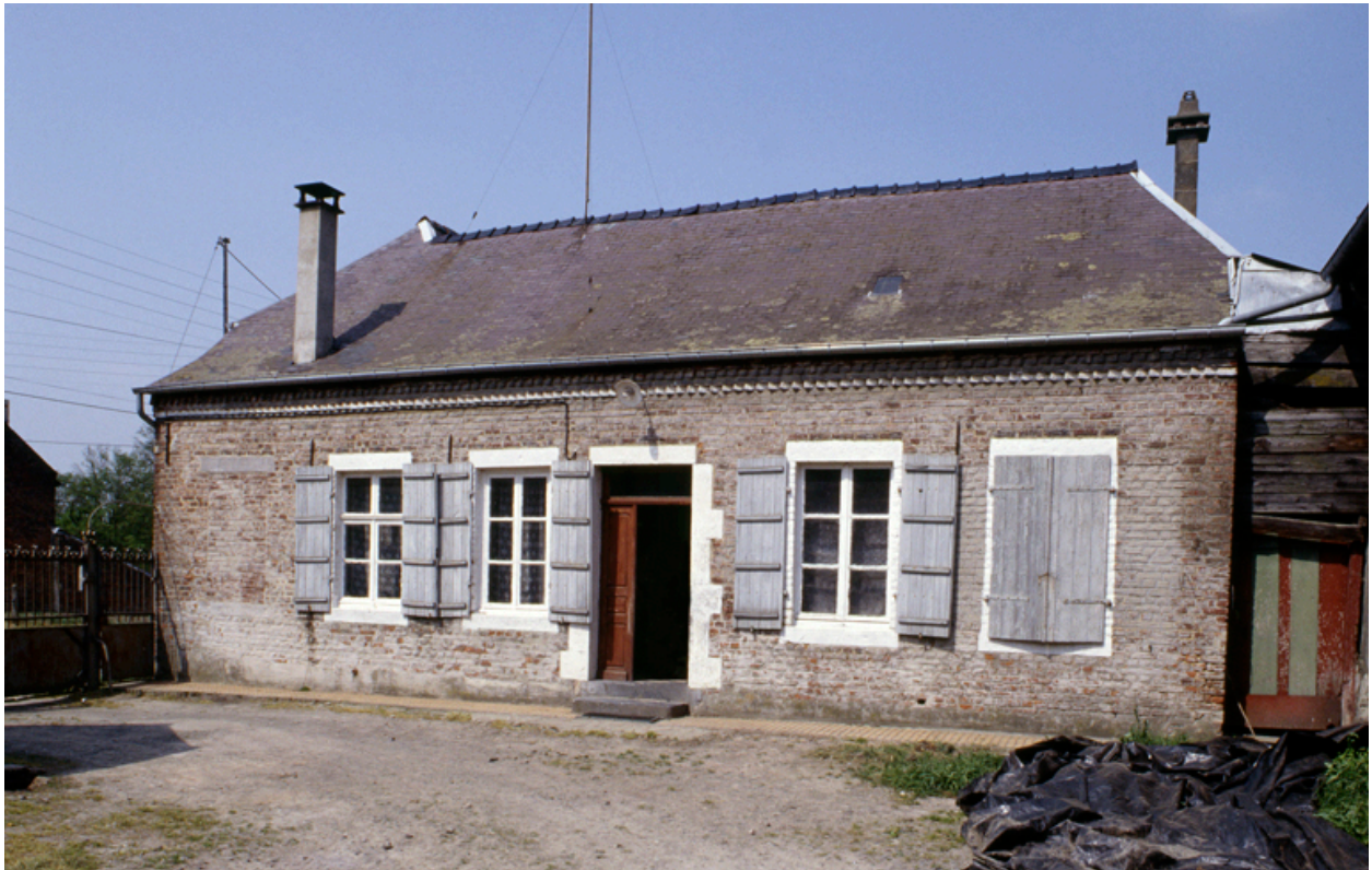
Vue de la façade du logis.
