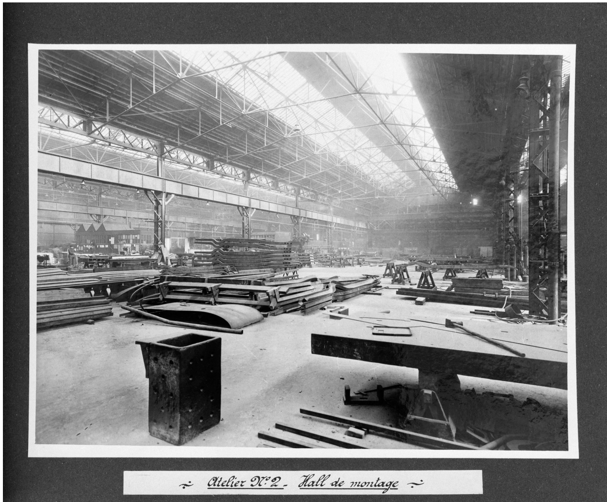
Atelier n° 2 : le hall de montage, 16 février 1940. Photographe inconnu (coll. part., archives Cerec).
