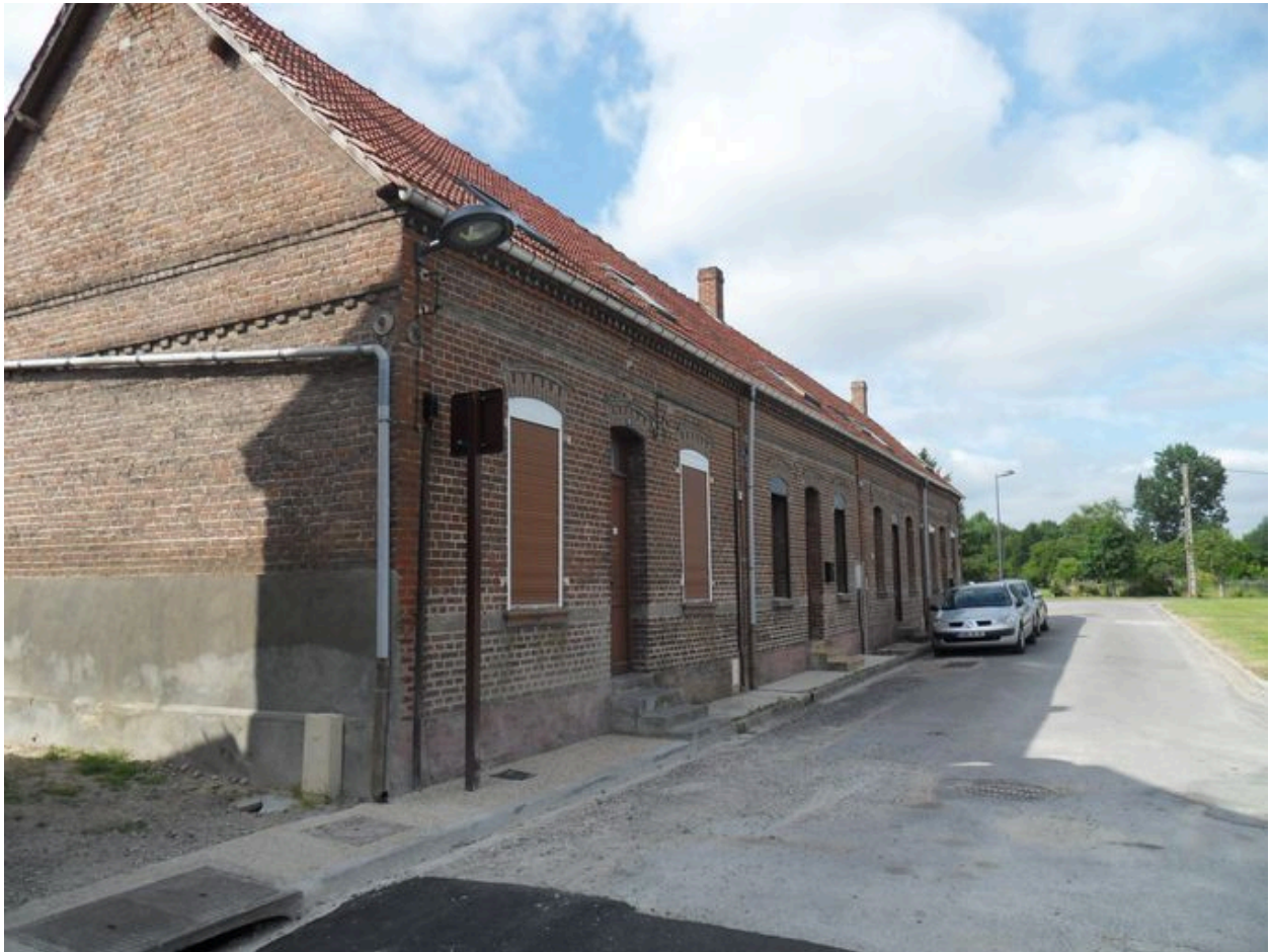
Logements, 39 à 45 rue Victor-Hugo (ancienne ruelle Blond).
